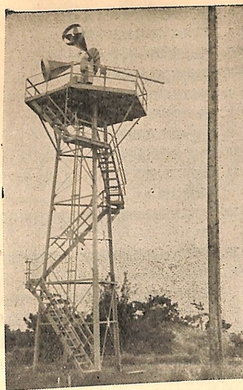
圖四 固定式 A.P.T. 地面接收站之天線
