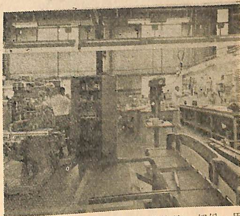
圖二 技術工廠，為氣球基地設施的一部份，用以校驗、改良、修理氣球所帶的儀器包、繩索系統等。
