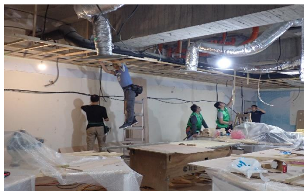
圖 14 值班中心舊有設施拆除過程
