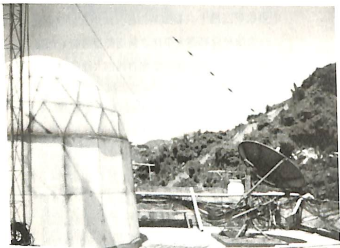
圖六：衛星系統之接收天線，圖右為原小碟型同步天線，民國75年6月改用左側防護罩內之大型天線（目前轉用為高解系統之同步衛星接收天線），三角架上即為軌道衛星接收天線。
