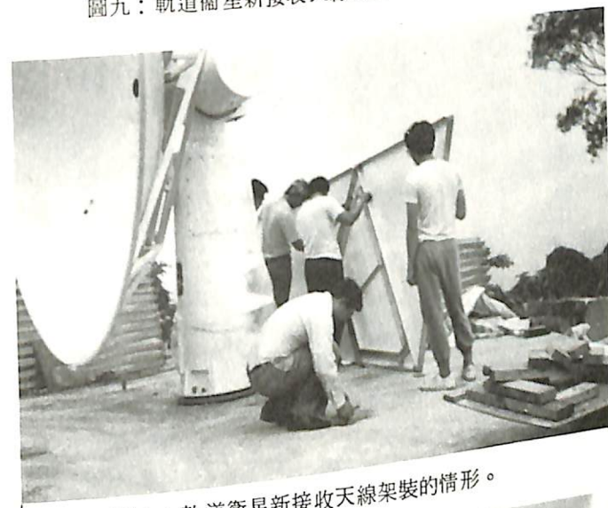
圖九：軌道衛星新接收天線的基座施工情形。
