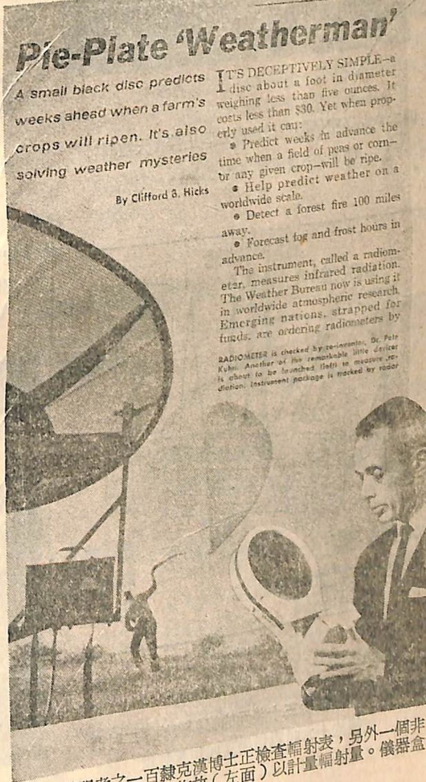
圖一 發明者之一百綠克漢博士正檢查輻射表，另外一個非常小的器具即將施放（左面）以計量輻射量。儀器盒乃以雷達追蹤。
