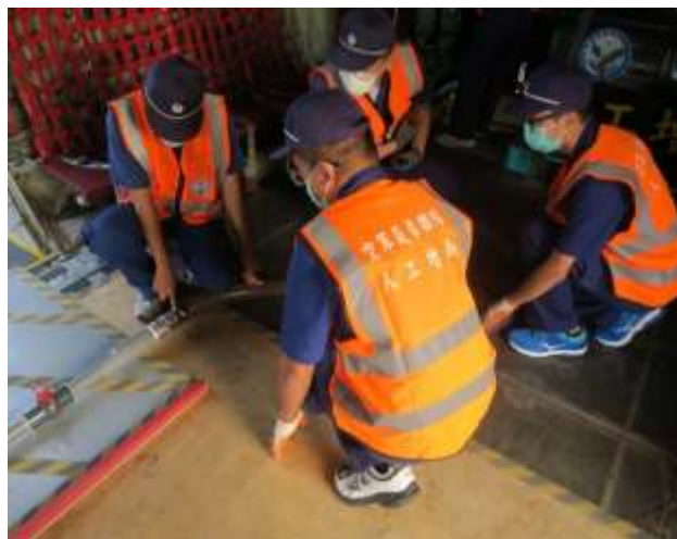
圖7 確認管路接頭接合情況
